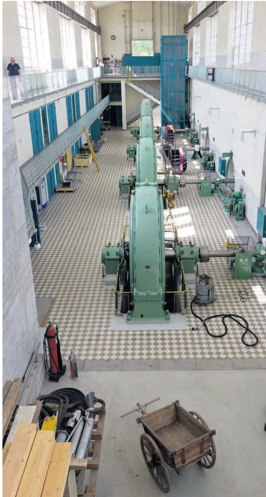
Zeugen der Industriegeschichte. Noch produzieren zwei der vier traditionellen Francis-Maschinen (Bild) neben modernen Straflo-Maschinen Strom.
